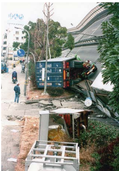
被災当時の阪神高速3号神戸線 (阪神・淡路大震災「1.17の記録」より)
