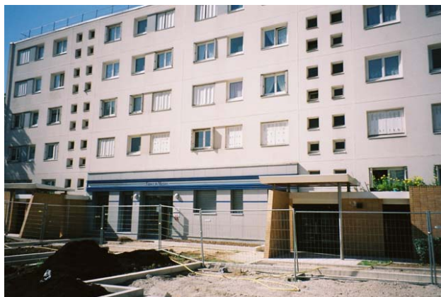
図6 再生工事（レジダンシャリザシオン）の状況
