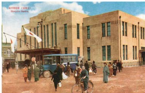
新宿停車場 (大正14年竣工) (震災復興絵はがきより)
