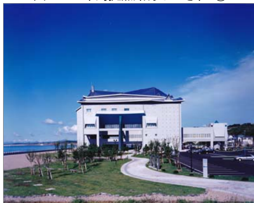
図2 日本海拠点館あじがさわ ①
