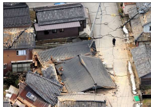
写真4 能登半島地震で 家屋が大きく崩れた中を歩く人
