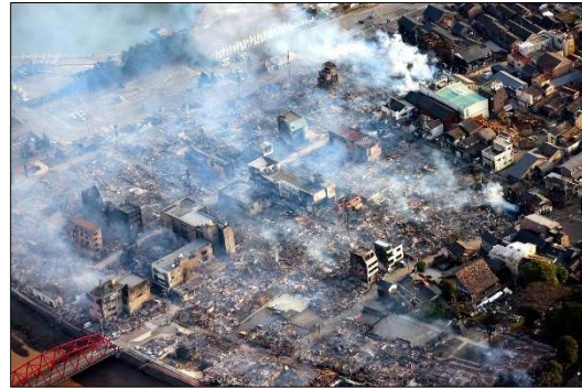
写真1 火災が続く輪島市の市街地
