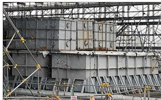
写真7 汚染土を保管しているコンテナ
