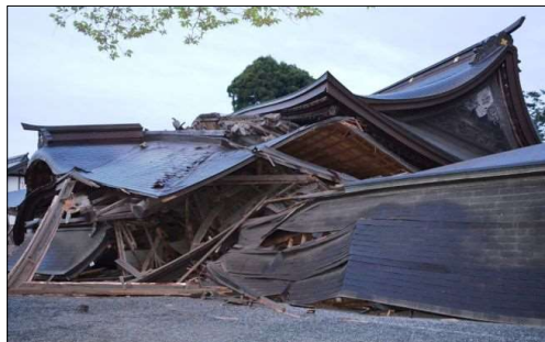
写真12 倒壊した阿蘇神社の楼門 (2016.4.16 熊本県阿蘇市)
