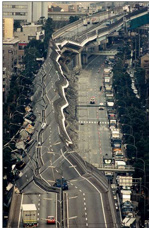
写真14 なぎ倒された東灘区の 阪神高速神戸線。道路上を走る車も横倒しに (1995.1.17 神戸市)
