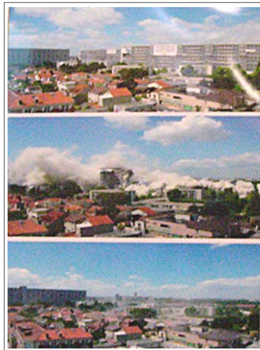
図1 ANRU本部掲示写真（2005年訪問時撮影） 住宅地背後の高層団地の爆破解体とその後の状況
