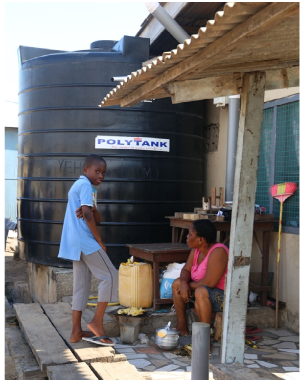
写真 2 共同水栓 (アクラ) : 水道は敷設されているが、頻繁な断水のためタンクも備える。
