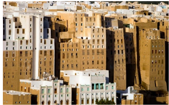
写真5 南イエメン シバーム 木筋泥壁高層建築群 セメント不要の伝統都市 事例
