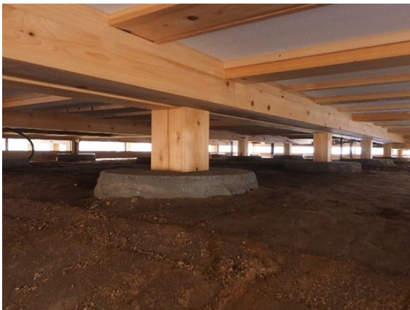
写真3 石場建・伝統木造住宅・開放型床下 T. Ayabe 2021
