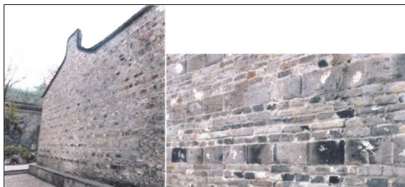
写真4 中国 鳥鎮(水辺伝統集落) セメント不要の伝統壁 事例 撮影 2019
