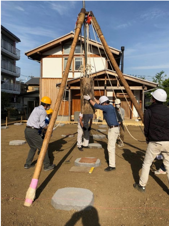
写真2 石場建住宅・基礎石打ち込み 「よいとまけ」作業 T.Ayabe 2021
