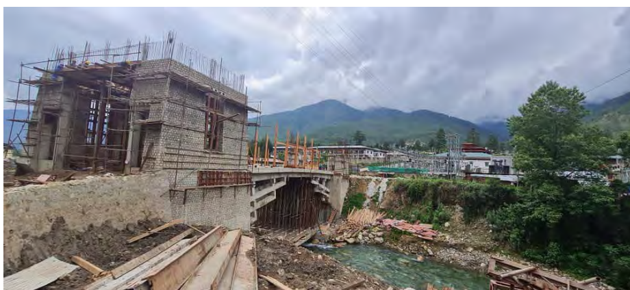
図 パングリザンパ僧院の車道橋（カンチレバー橋）。ブータンの伝統的な橋（baa-zam）の建築要素をすべて取り入れた設計で、パングリザンパの遺産イメージを高めている。
