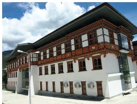
図9. Thimphu TechPark外観 (2013年7月筆者撮影)
